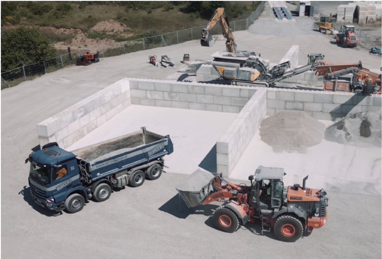
Betonrecycling bei SCHICK.
