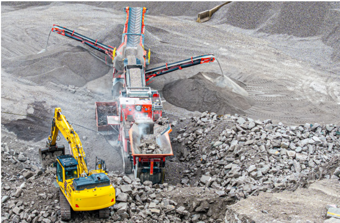
Ein wichtiger Schritt zur Ressourcenschonung: A1 Schmittenhäusl, die Betonrecyclinganlage gewinnt aus Abbruchmaterial hochwertiges Recyclingmaterial.
